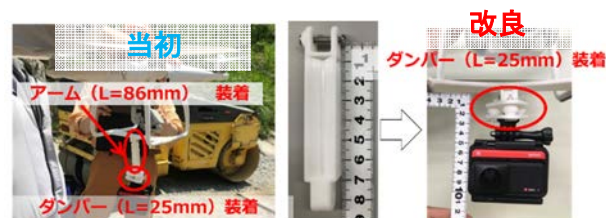
図-6 360° カメラの取付
