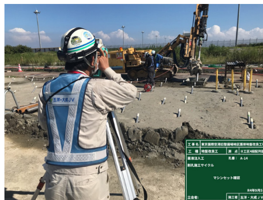
図-5 従来の削孔方向確認作業の様子
