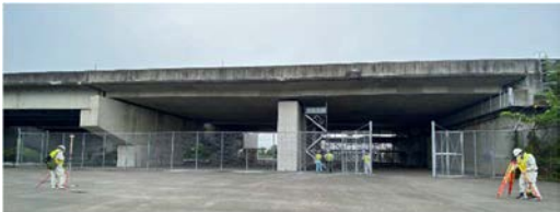
写真-1 関越道 五明橋全景
