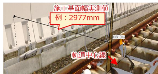
図4 施工基面の幅の計測（点群）
