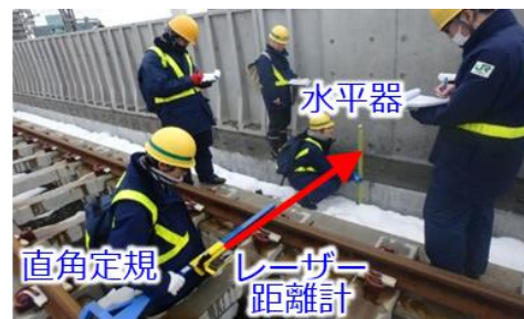
図3 施工基面の幅の計測（従来）
