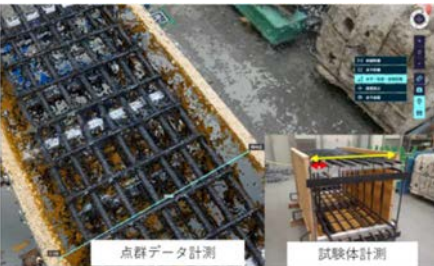
図-2. ②室内モックアップ試験体
