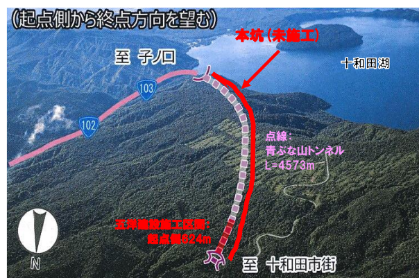
図-2 青ぶな山トンネル施工位置図 (提供：東北地方整備局 青森河川国道事務所)
