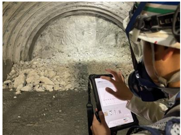
写真-1 タブレットを使用した切羽観察
