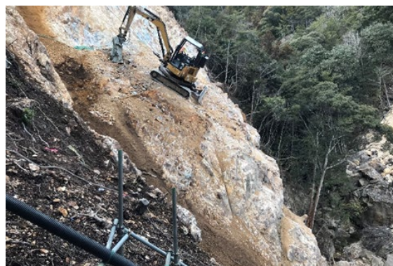
写真-1 高所無人掘削機の掘削状況
