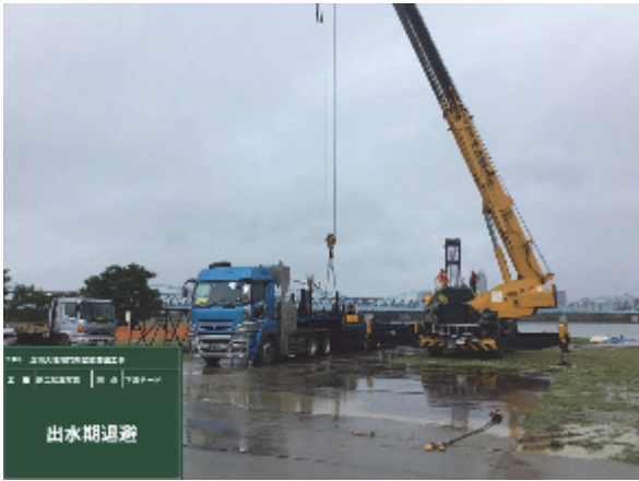
写真-2 台風 4 号による退避作業状況
