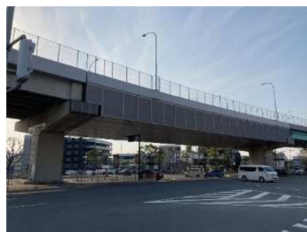
写真-2 しゅん工
