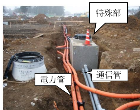
図 1. 電線共同溝の構成部材
