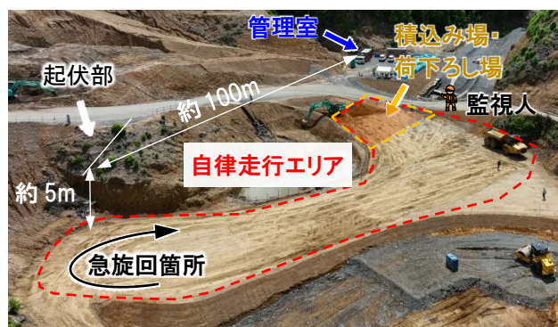
写真-2 実験ヤード全景
