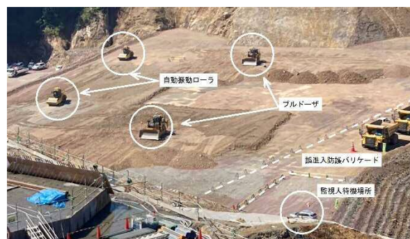
図-3 堤体盛立自動施工状況
