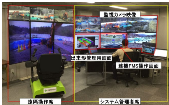
写真-1 建機 FMS 操作状況
