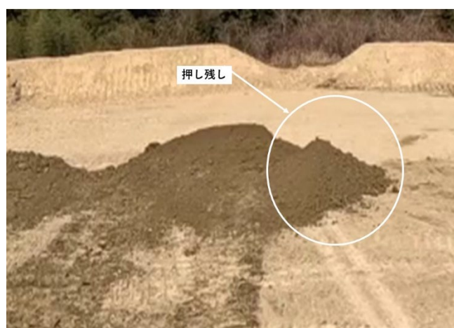
図4 押し残し発生状況
