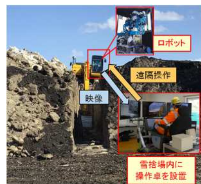
図-2 プレ開発での雪捨場での遠隔による溝掘り作業
