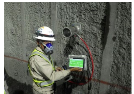
写真-3 省力化ロックボルト引抜き試験機
