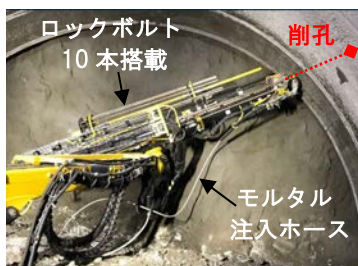
写真-5 ボルト打設ユニット
