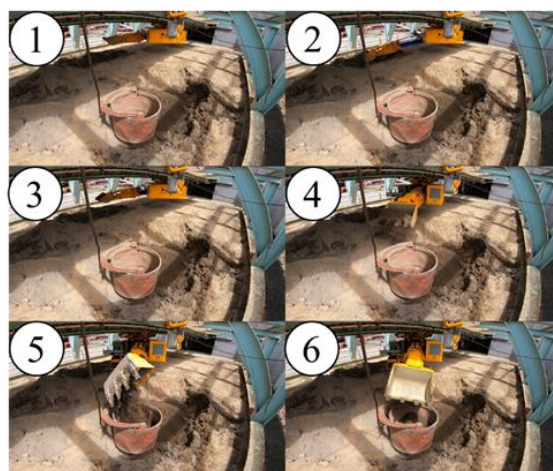
図-2 掘削作業状況
