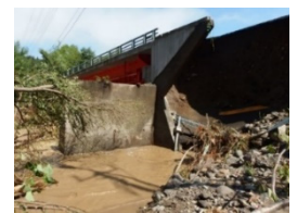
図-2 小型ドローン機体概要 図-3 橋台背面土流出事例
