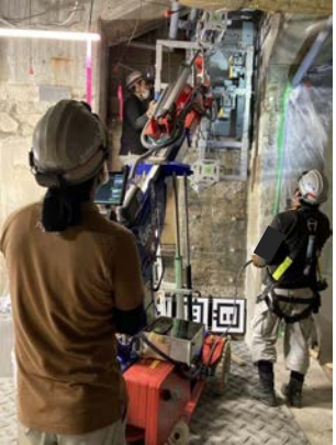
写真-4 鋼板設置状況
