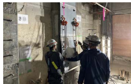
写真-1 鋼板設置状況(人力)
