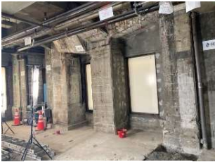
写真-3 現場写真
