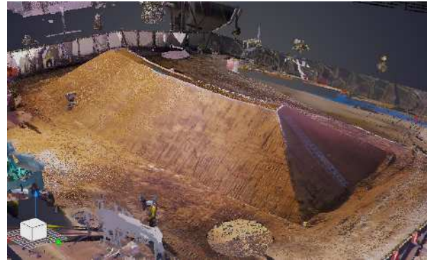
図-1 「ため池」築堤全体
