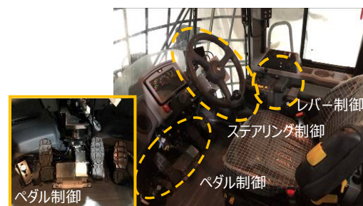
図-2 遠隔操作制御装置
