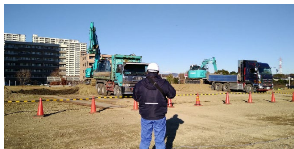
写真-3 自動運転ショベル 2 台への動作指示
