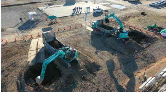
写真-4 自動運転ショベル 2 台の同時稼働状況
