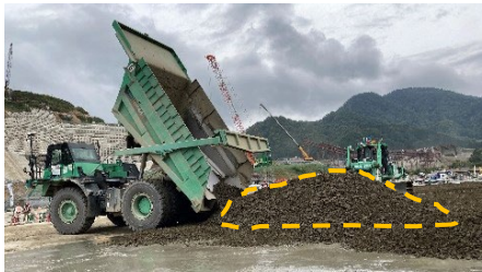
写真-3 DT によって荷下ろしされた材料
