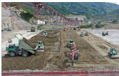
写真-1 成瀬ダムでの施工状況
