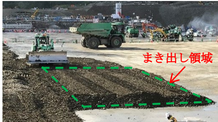
写真-4 DRL によるまき出し作業
