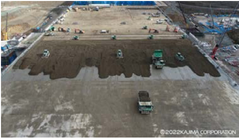
写真-1 自動化施工状況
