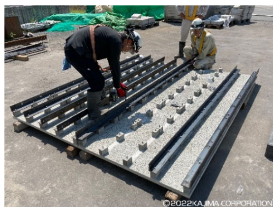
写真-2 地組状況
