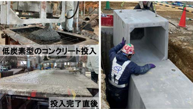
図-7 製作状況・施工状況
