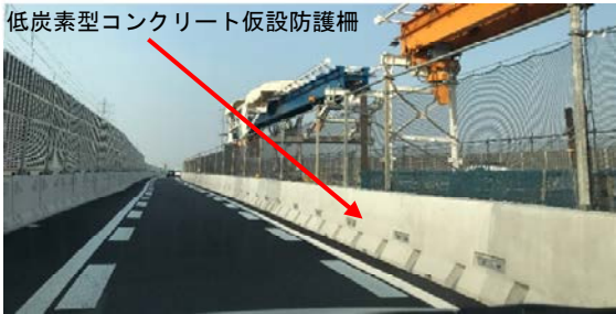
写真-2 低炭素型コンクリートの仮設防護柵設置状況
