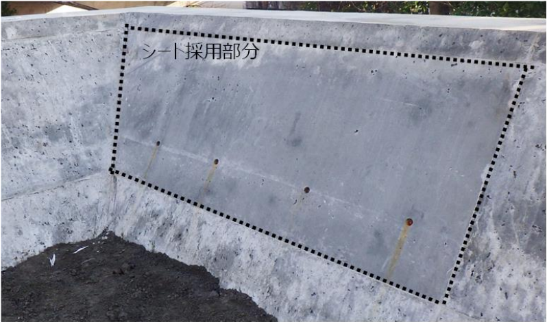
図－4 実現場での適用事例(施工：佐藤工業(株))
