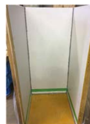
写真2 型枠へのシート貼付けの様子
