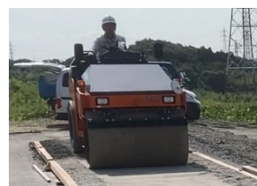
転圧状況（4t 振動ローラ）
