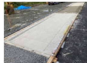
転圧後の状況（4回転圧）
