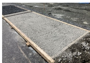
敷均し後の状況
