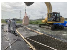
ベントナイト砕石投入状況
