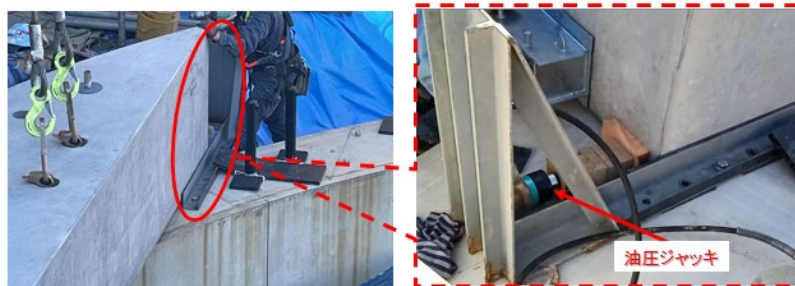
図-9 ガイド鋼材・背面鋼材
