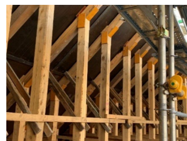
写真-3 木製支保工設置状況
