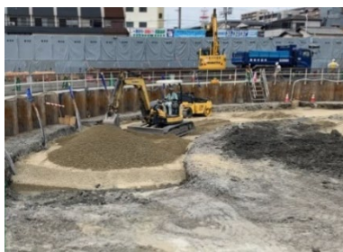
写真-1 砕石置換え実施状況
