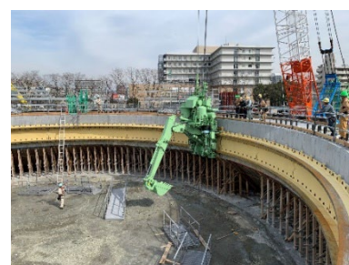
写真-4 走行レール設置状況
