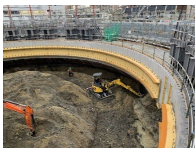
写真-6 皿板撤去及び土砂押し込み状況
