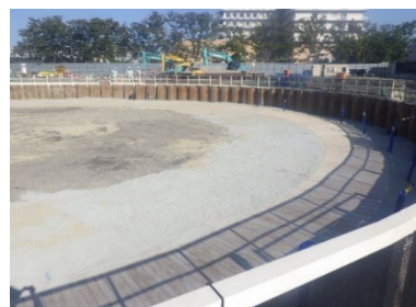
写真-2 皿板設置完了
