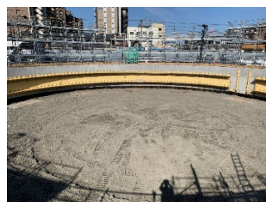
写真-7 初期沈設完了
