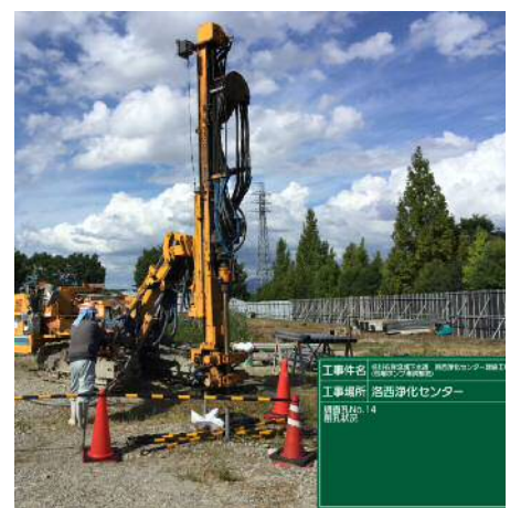
図4 施工状況写真
