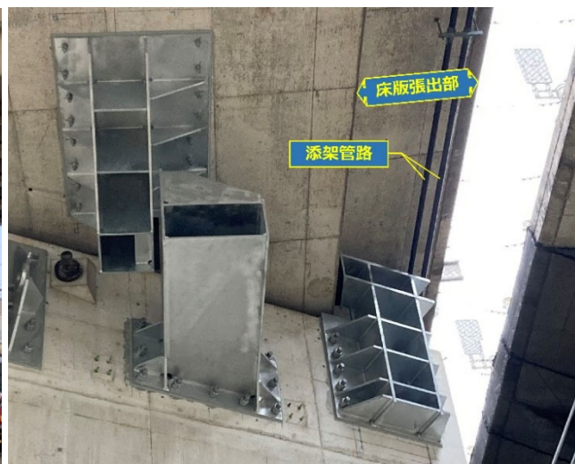
写真- 4 設置完了した鋼製部材
