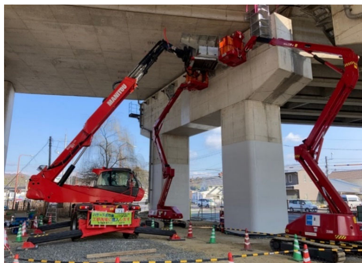
写真- 3 テレハンドラーを使用した設置状況
