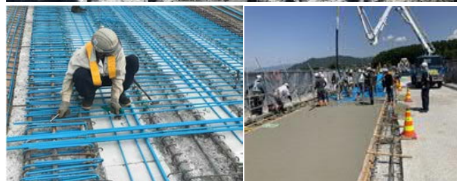
写真-3 切削後～コンクリート打設状況
