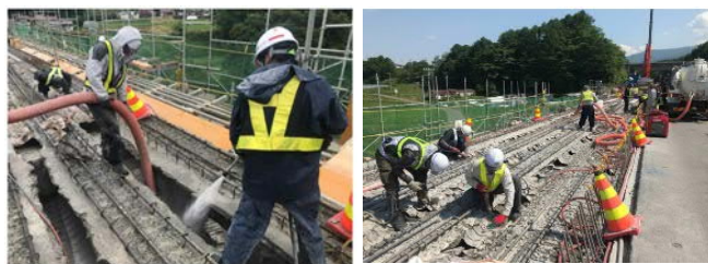
写真-1 円筒型枠損傷補修状況
