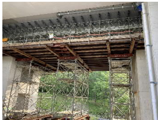
写真-1 支保工設置状況
