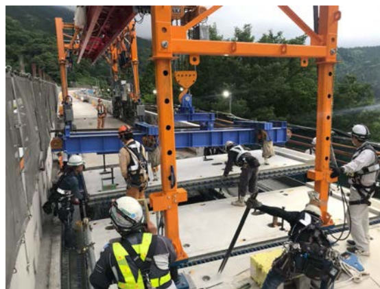
写真-1 プレキャスト PC 床版架設状況
