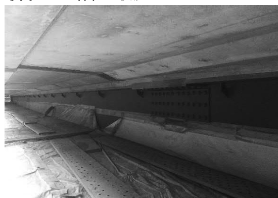
写真-6 実橋への適用（脱枠後）
