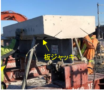
写真-4 板ジャッキ設置状況
