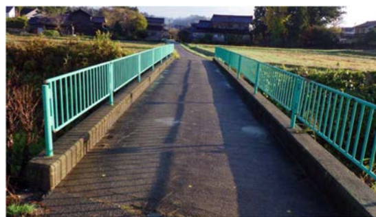
写真-1. 橋梁全景
