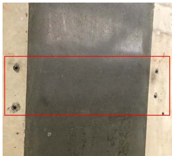
写真-2 計測器撤去後 全景 (走行側)
