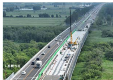
写真-1 春期施工状況
