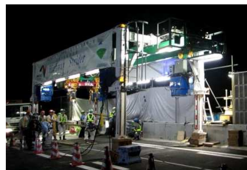
図-1 移動式床版架設機 (ハイウェイストライダー)
