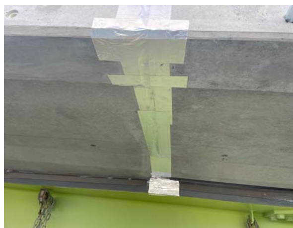
写真-1 アルミテープ設置状況
