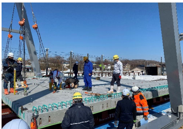
写真-1 PC床版架設状況
