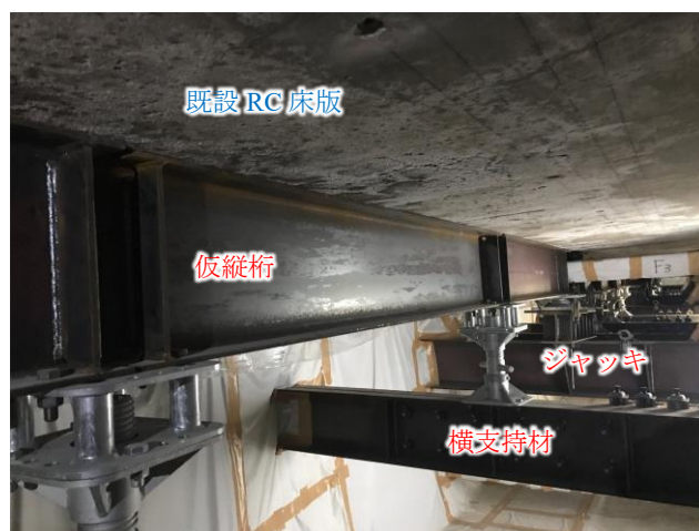
(c) 施工状況
