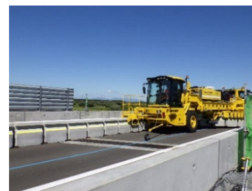
写真-2. ロードジッパーの稼働状況
