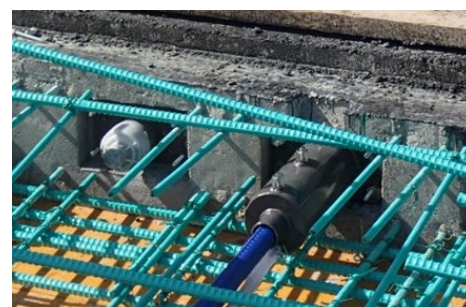
写真-1. デッドアンカー(左)と PC 鋼材接続具(右)
