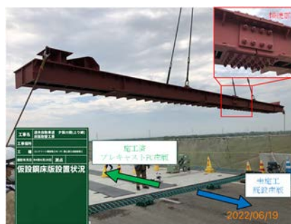
写真-1 仮設鋼床版設置状況
