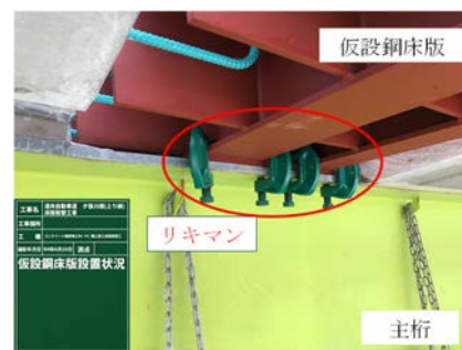
写真-2 リキマン設置状況
