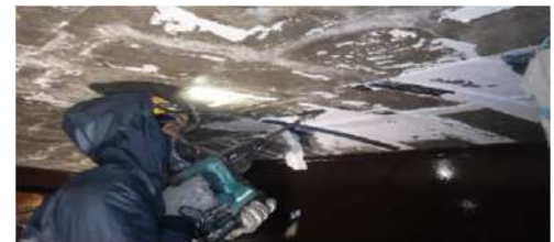
写真5 CFRPプレート除去状況
