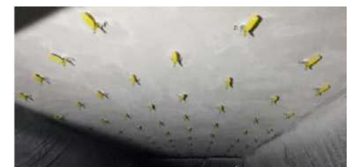
写真7 エポキシ樹脂注入状況
