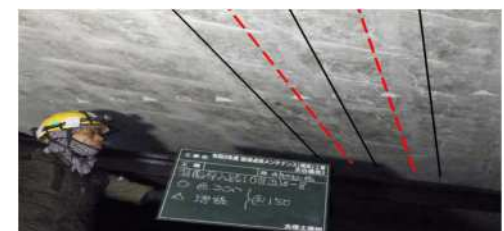
写真6 クロスカット(樹脂導入路)増設
