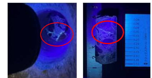
写真8 小径コア採取による樹脂注入確認
